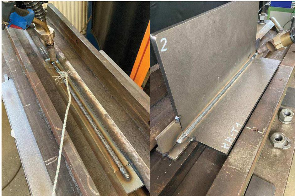
**Abbildung 37:** Beispielhafte Herstellung eines Stumpf- und T-Stoßes; teilweise  $t_{8/5}$ -Messung mit Thermoelementen
